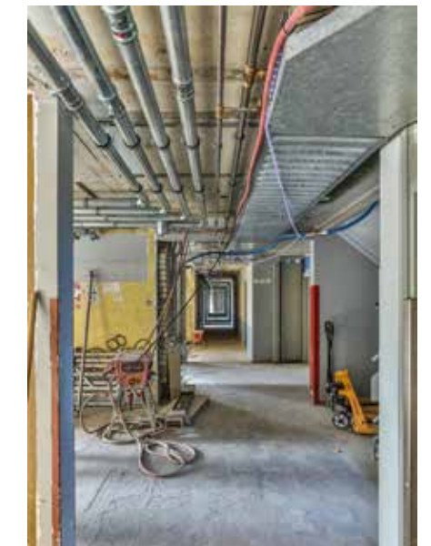
Tijdens de vernieuwing wordt de Duindoornflat all-electric gemaakt. Koken gebeurt voortaan elektrisch en voor de verwarming wordt een koppeling gemaakt met het warmtenet van WarmteStad.
