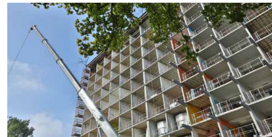
Tijdens de vernieuwing is de complete buitengevel van de Duindoornflat verwijderd, inclusief de balkons, waarna de flat aan beide lange zijdes is uitgekraagd.
